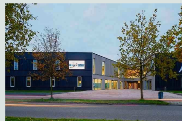
Nieuwbouw Uniformberoepen ROC Friese Poort, Leeuwarden. WAA Wind Architecten Adviseurs, Drachten. Projectarchitect: Sytze Jan Zoodsma. Opdrachtgever: ROC Friese Poort. FOTO GERARD VAN BEEK
