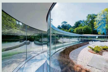
Bezoekerscentrum Park Vijversburg, Tytsjerk. Studio Maks i.s.m. Junya Ishigami & associates, Rotterdam. Projectarchitect: Marieke Kums. Opdrachtgever: Stichting op Tautenburg.
